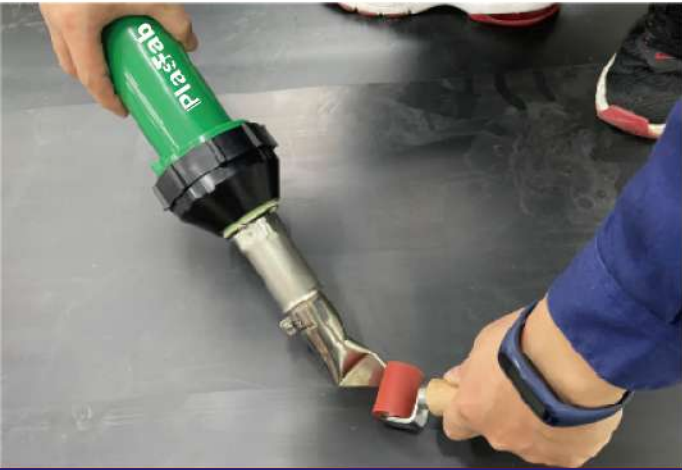
HDPE Geomembrane Welding PFE1600A
