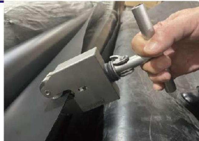
HDPE 1.5mm Geomembrane PFE-PULLER 1
