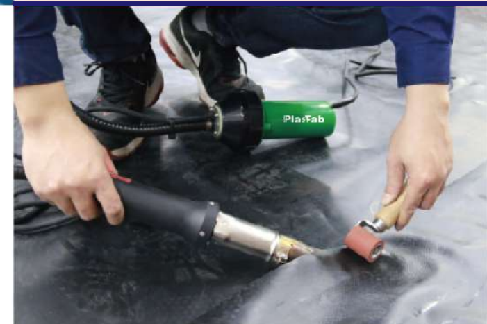
HDPE Geomembrane Welding PFE2000
